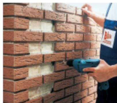
Mit Spezialschraubdübeln werden die Systembauteile in den eingeformten Befestigungsbuchsen befestigt. Die Eckelemente werden für jedes Haus nach Aufmaß in passender Größe gefertigt. So werden Öffnungen mauerwerksgerecht eingebunden.
