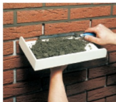
Die Systembauteile werden durch PU-Schaum miteinander verbunden. Die Fugen werden mit Fugenmörtel gefüllt der mit dem Fugeisen von einem Reibebrett in die Fuge eingearbeitet und geglättet wird.
