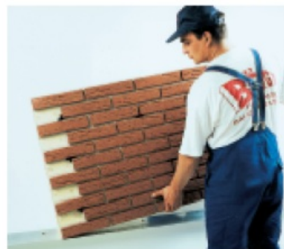
Ein Aluminium-Profil gibt dem Systemklinker Halt und einen Abschluss nach unten. Ein Fundament wird nicht benötigt. Die Systemplatten sind ca. 112,5 x 69 cm groß und lassen sich auch allein aufsetzen.
